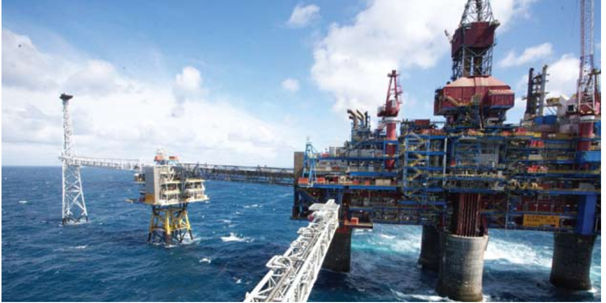
➤ Ο εξοπλισμός του συστήματος άντλησης και αποθήκευσης διοξειδίου του άνθρακα στο Sleipner στα ανοικτά της Νορβηγίας.
