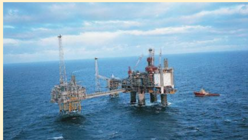
Ο εξοπλισμός του συστήματος άντλησης και αποθήκευσης διοξειδίου του άνθρακα στο Sleipner στα ανοικτά της Νορβηγίας.
